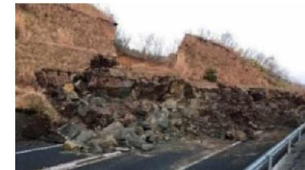
〈のり面崩壊による暫定2車線区間の通行止め〉
