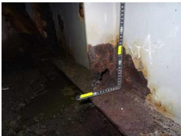
国管理 主桁腐食・欠損
